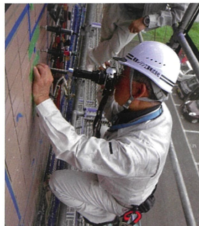
■マトロンルーペによる孔内測定 (目盛り1つが0.1mm)
